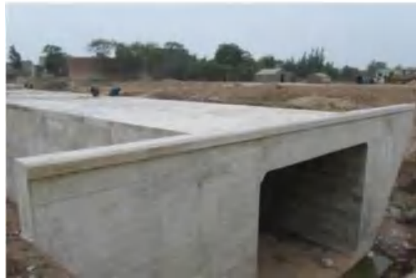
图 2.3-9 钢筋砼箱涵样例
